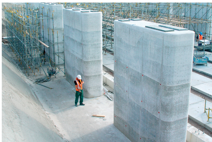
Pijlers Akwadukt Langdeel (najaar '06)
