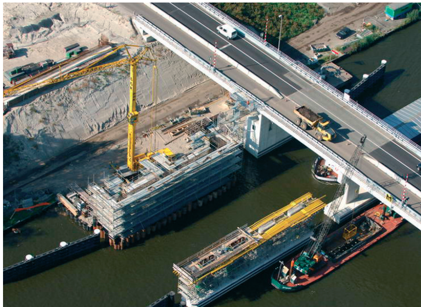
Basculepijler en oplegpijler Fonejachtbrug in aanbouw (najaar '06)
